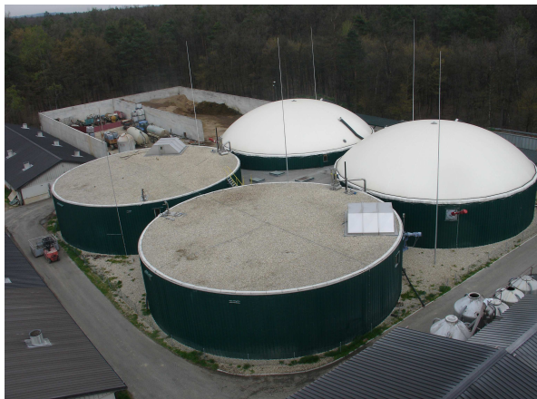
Slika 1: Značilna podoba za bioplinsko napravo: armirano betonski digestorji s pokrovi z dvojno membrano. Na sliki je Bioplinarna BIOPLIN, Kolar Marjana s.p. v Logarovcih (Križevci pri Ljutomeru), ki ima 1000 kW motor za proizvodnjo elektrike, kot substrat pa uporablja prašičjo gnojevko, koruzno in travno silažo.
