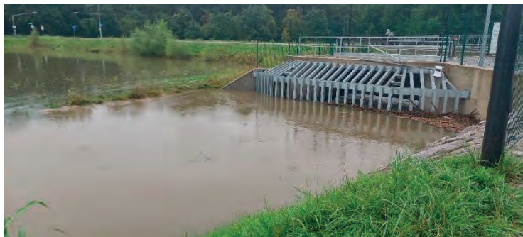
Slika 2: Aktivirana zapornica SZ Brdnikova. Na levi strani Glinščice se voda, bogata s sedimenti, razliva na sosednji travnik, ki je bil pred posodobitvijo njivske rabe (Golob, 5. 8. 2023)
