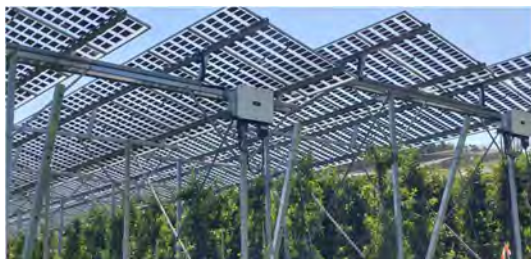
Slika 1: Dvojna raba kmetijskega zemljišča v sadovnjaku. Nad vrstami v sadovnjaku so postavljeni tako imenovani zebrasti fotovoltaični paneli, ki imajo 49 % prepustnost svetlobe in 300 W moči. (foto: B. Germšek)
