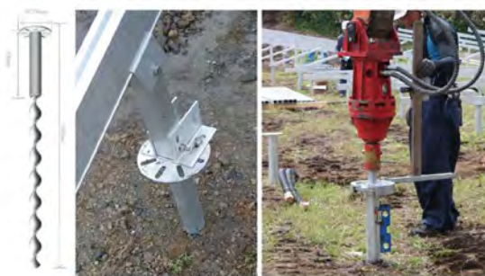
Slika 7: Svedrska izvedba temeljenja APV (Vir slike: Hugergy, 2022)
